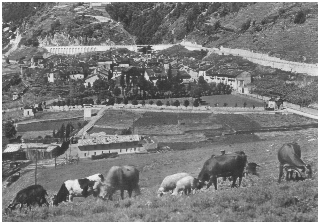
Fotografia scattata dalla rampa del Forte dopo la prima guerra mondiale dalla quale si può riconoscere a destra la Cappella di San Rocco e San Sebastiano, di fronte ad essa il nuovo monumento ai caduti del conflitto bellico e il viale reso carrabile.
