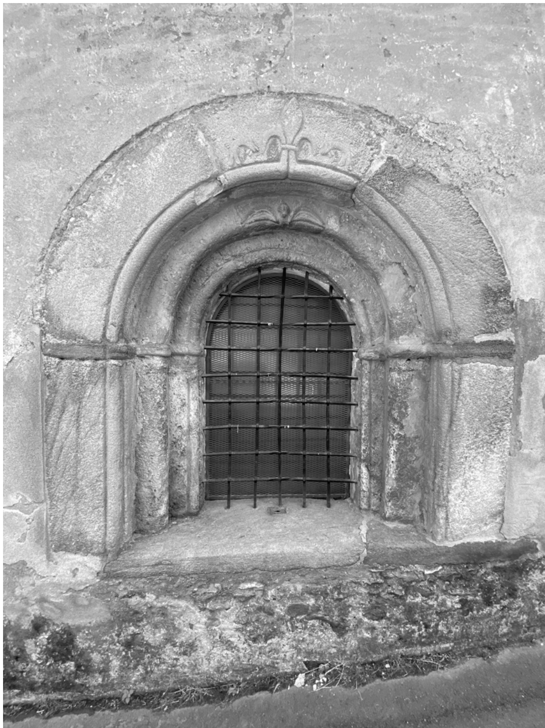
Finestra in facciata nord.
