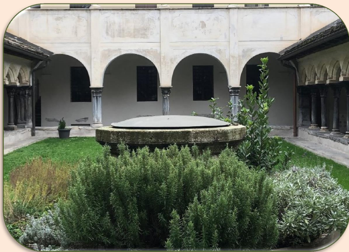
Il lato est del chiostro
